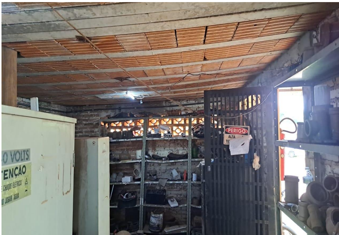
Parte interna da edificação
