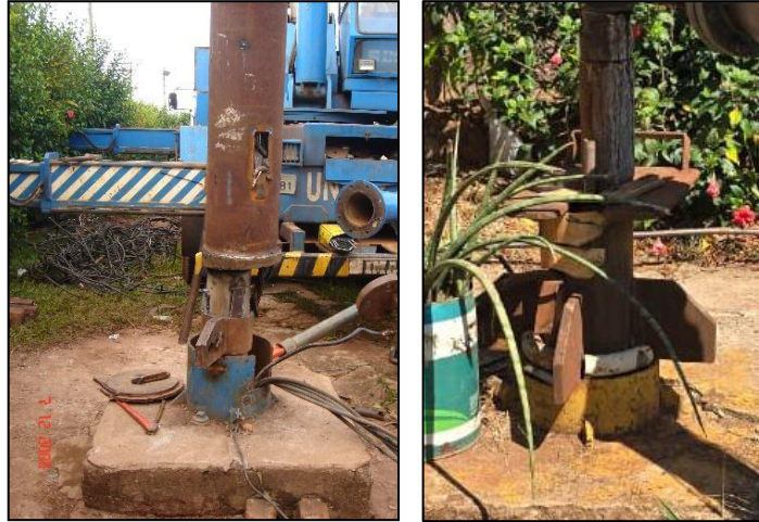
Figura 04 – PMSL-P.03 antes e depois do reencamisamento.
