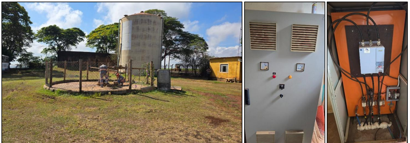
Figura 05 – Poço PMSL-P.04 durante visita técnica da Uniper.
