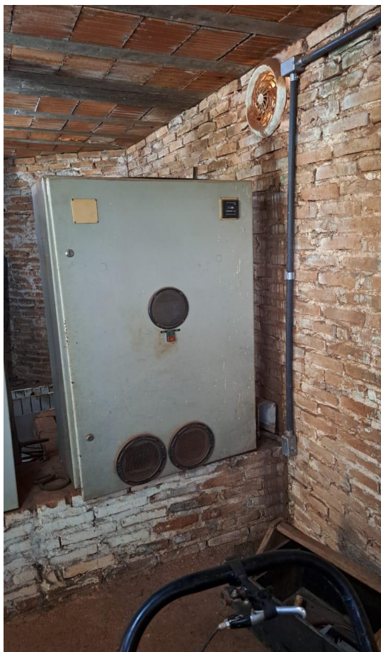
Quadro de comando da bomba de extração.
