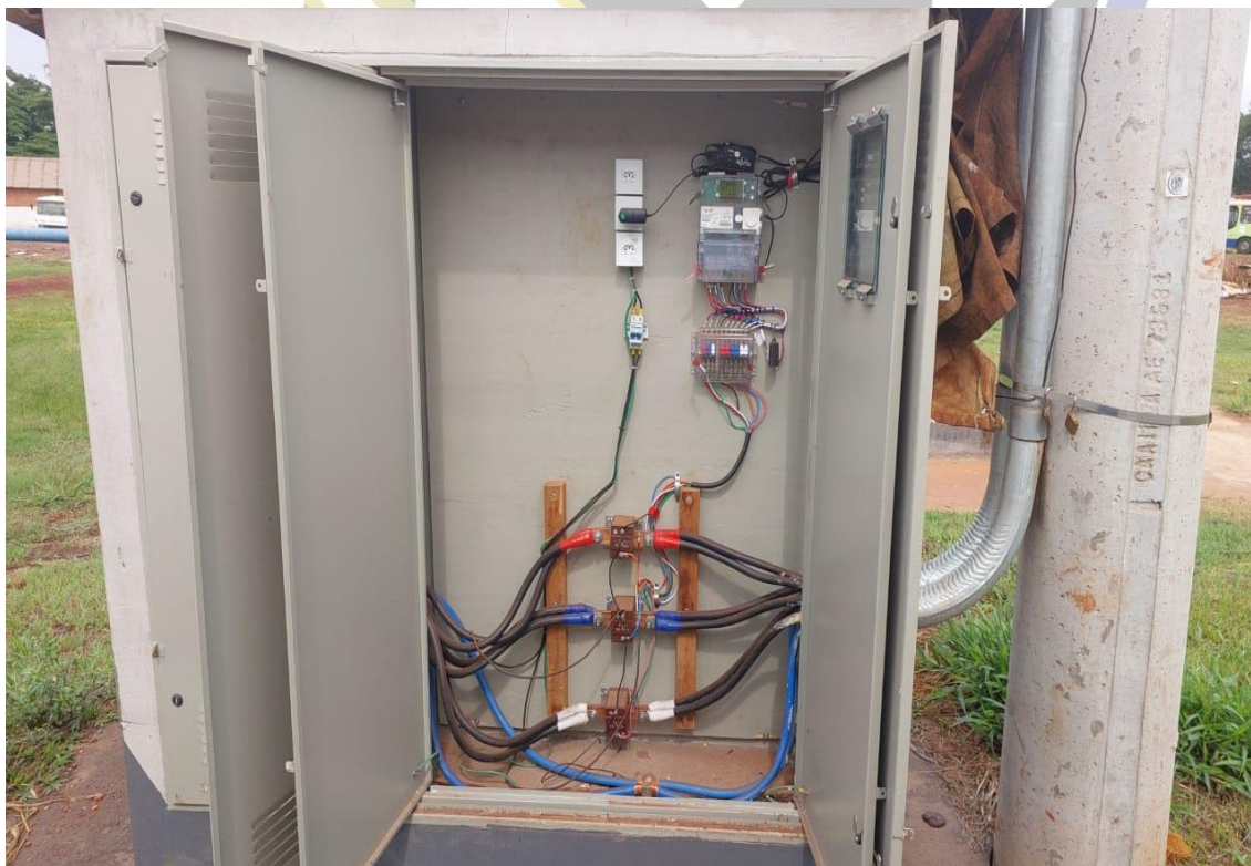
Compartimento de medição
